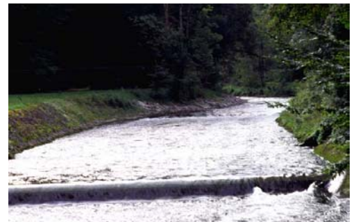
Ufer- und Sohlverbauung an der Glatt
