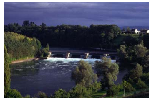
Wehr des Kraftwerks Rheinau
