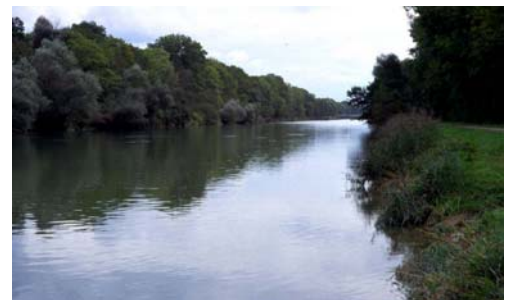
Begradigter Unterlauf der Thur
